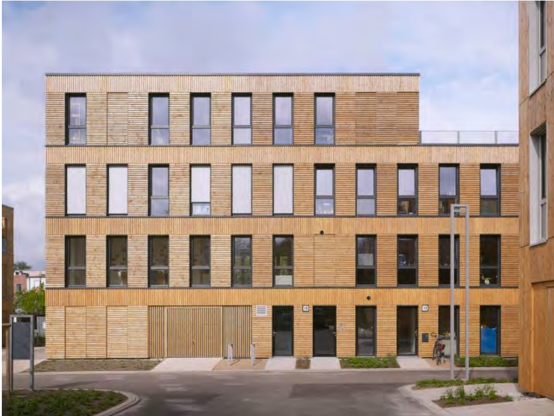
Referentie: houten gevelbekleding gebouw met horizontale belijning. Neue Hamburger Terrassen / LAN Architecture
