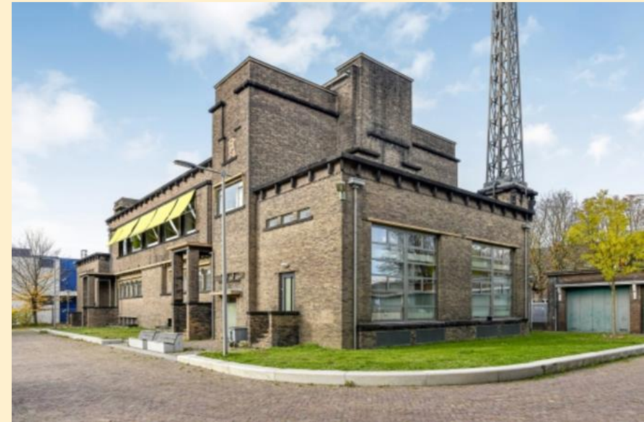
Kantoorpand Op Naar Nul
